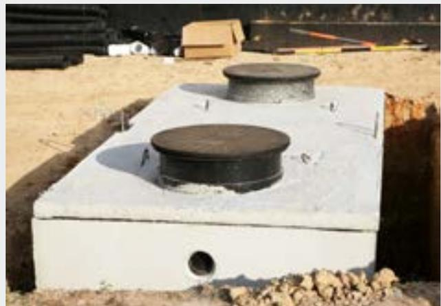
Abb. 3 Faulbehälter mit Wasserzufuhr aus einem Privathaushalt
