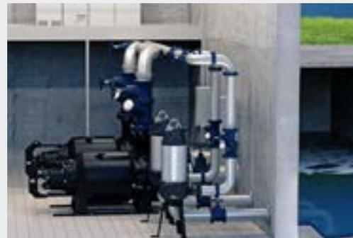
Abb. 23 Zwei horizontal installierte Grundfos Abwasserpumpen mit ihrem jeweiligen Druckleitungssystem und den Saugleitungen zum Sammelbrunnen
