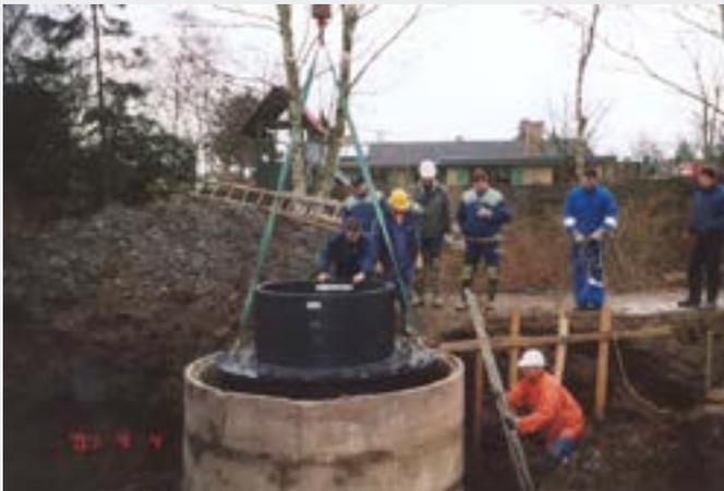
Abb. 46 Eine neue vorgefertigte Pumpstation wird in eine vorhandene Betonstruktur abgesenkt
