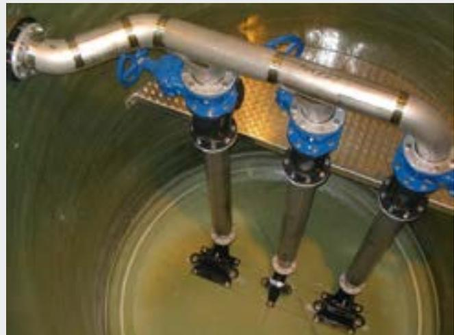
Abb. 28 Pumpstationen mit Edelstahlrohren und einem Durchmesser von 3000 mm sowie fest installierter Serviceplattform
