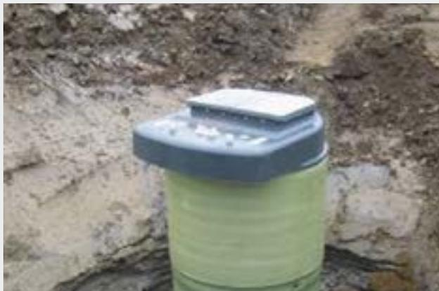
Abb. 18 Pumpstation mit erweitertem oberen Deckel aus glasfaserverstärktem Polyester, bereit zur Installation eines Steuerschranks
