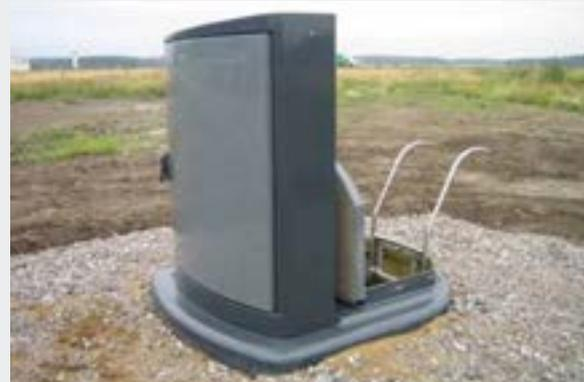
Abb. 19 Steuerschränk, montiert auf dem erweiterten oberen Deckel aus glasfaserverstärktem Polyester
