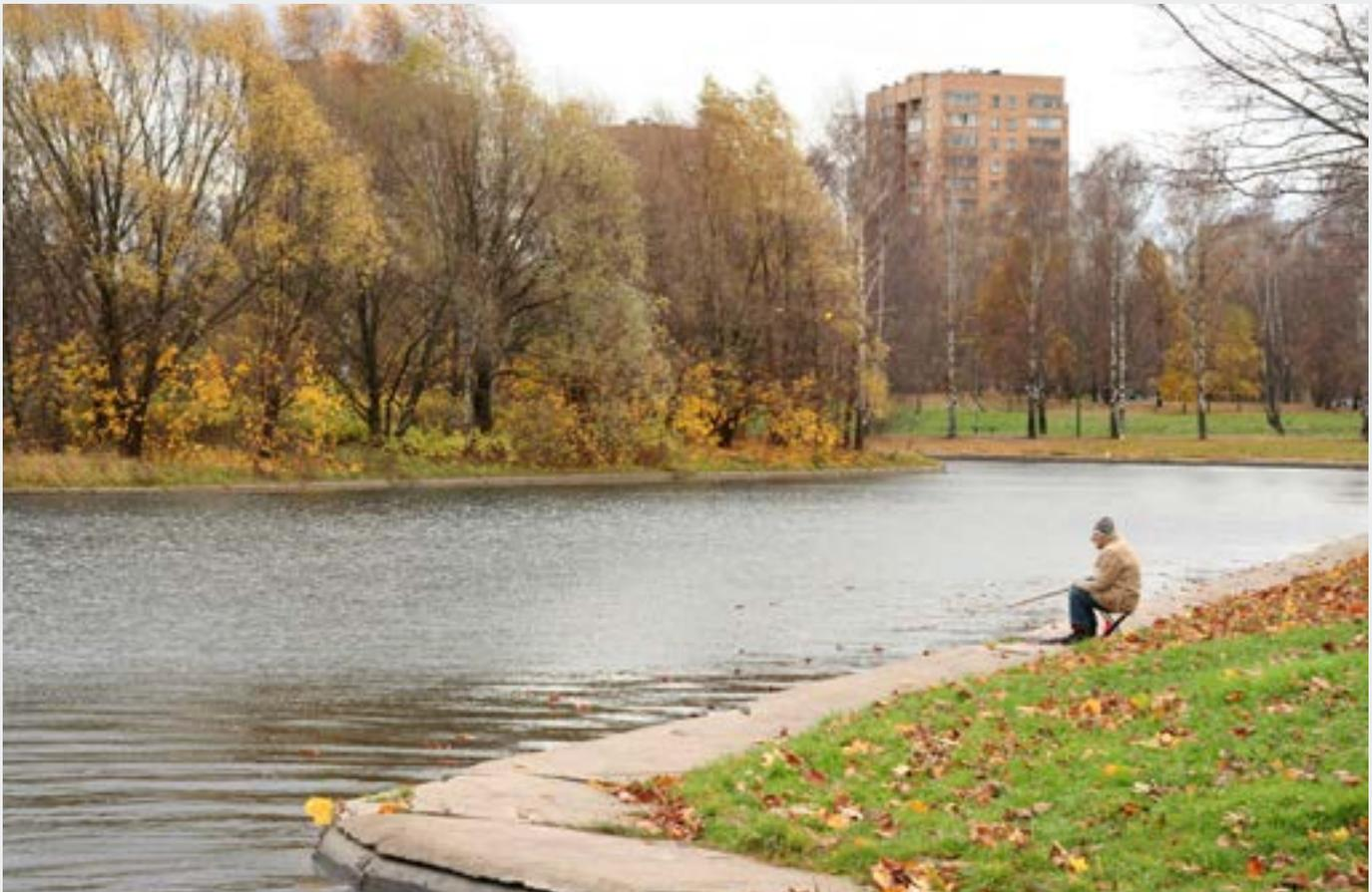
Abb. 5 Rückhaltebecken zum Sammeln von Regenwasser und Vermeiden überfluteter Straßen nach schweren Regenfällen
