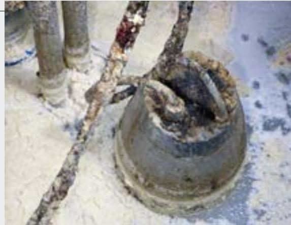
Abb. 1 Eine von zwei SE-Pumpen zum Fördern von Abwasser mit Chemikalien mit großen pH-Streungen aus dem CIP-Reinigungsprozess einer Käserei
