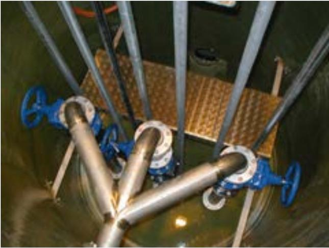
Abb. 20 Pumpstation mit DC-Rohrsystem für drei Pumpen und anhebbarer Serviceplattform
