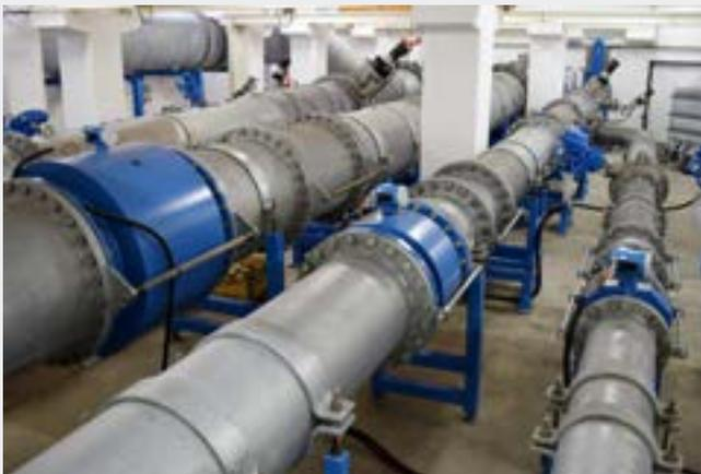
Abb. 6 Verrohrung und Anordnung von Messgeräten unter dem Boden
