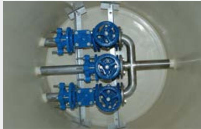
Abb. 23 Ventilkammer für zwei Hochdruckpumpen und Saugstrahlrohr zwischen den beiden Druckleitungen
