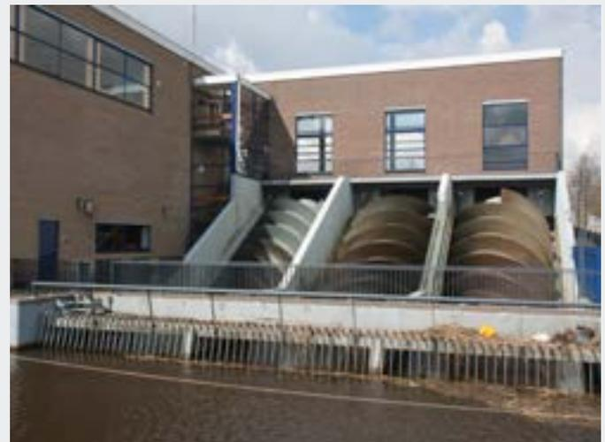
Abb. 5 Drei Archimedische Schraubenpumpen in der Zulauf-Pumpstation einer Abwasser-Aufbereitungsanlage
