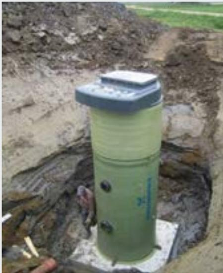
*Abb. 1 Pumpstation mit einem Durchmesser von 1800 mm auf Betonfundament zur Verhinderung von Aufschwimmen Die Oberseite der Station ist für die Installation einer Steuertafel oberhalb des Erdbodens vorbereitet.*
