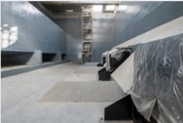
Abb. 10 Bild des verbesserten Pumpen-Sammelbrunnens mit Flusstörer, Zulaufverteiler unterhalb der Zulaufkammer und erweiterter Tiefe mit zusätzlicher Abtreppung zur Erhöhung der Geschwindigkeit in Richtung der Pumpen
