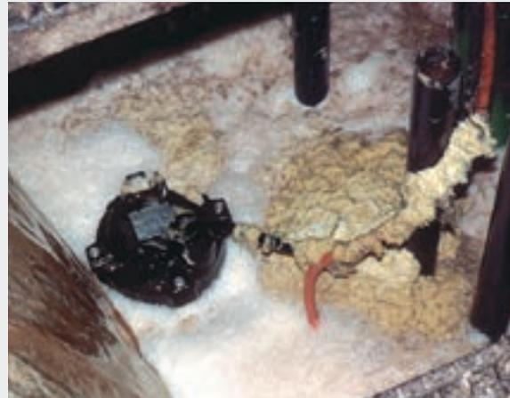
Abb. 2 Eine von zwei S-Pumpen zum Fördern von Prozesswasser mit einem hohen Gehalt abrasiver Partikel in einer Fertigungsstätte für Glaswolle
