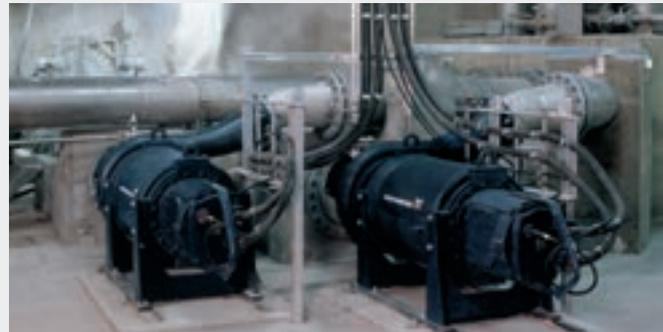
Abb. 13 Horizontale, tauchbare Grundfos Trockenschacht-Klärwasserpumpen mit Gestellen und Gleitschienen
