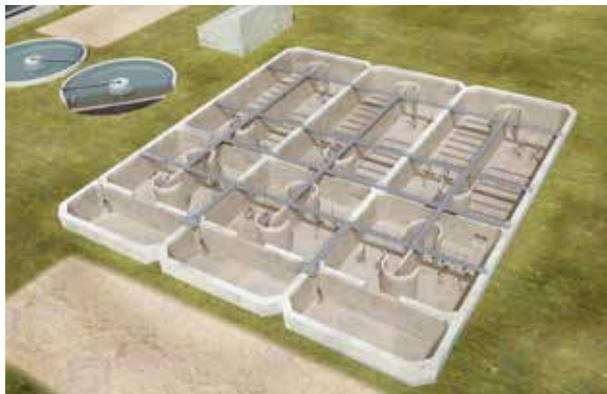
Die biologische Aufbereitung ist das am häufigsten eingesetzte Verfahren, um große Menge an organischen Substanzen und Nährstoffen aus dem Abwasser zu entfernen. Sie folgt der mechanischen Klärstufe und ist die aufwendigste und teuerste Klärstufe in einem Klärwerk.
