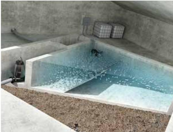
Die Ausfällung und Sedimentation sind weit verbreitete Verfahren zur Reinigung von Trinkwasser. In der Wasseraufbereitung werden Flockungsmittel eingesetzt, um die Sedimentation oder Filterbarkeit von kleinen Partikeln zu verbessern, die nur schwer durch Filterung allein entfernt werden können und das Wasser ansonsten trüben würden.
