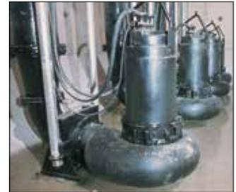
Die Grundfos Pumpen der Baureihe SEG, SL, SE und S sind für die Förderung von Abwasser, Schmutzwasser sowie großen Mengen an Oberflächen- und Grundwasser geeignet.
