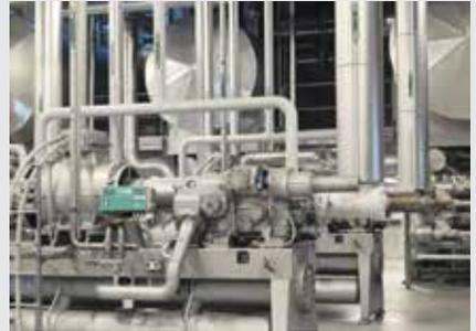
Abb. 9. Kolbenverdichter
