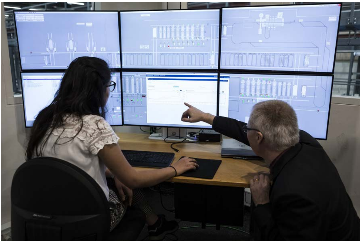
Überwachen und Steuern der Wasch- und Reinigungsanlage
