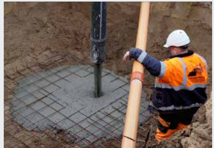
Abb. 14 Vor-Ort-Guss der Betonplatte
