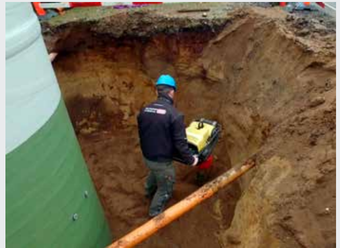
Abb. 19 Verdichtete Schichten von maximal 50 cm
