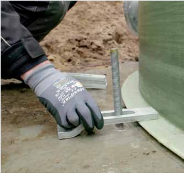
Abb. 18 Platzieren der Haltebügel
