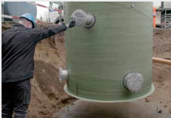
Abb. 16 Absenkung des Schachtes
