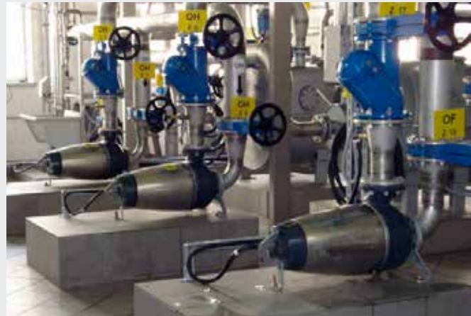
Abb. 3 Grundfos Klärwasserpumpen auf Einzelfundamenten
